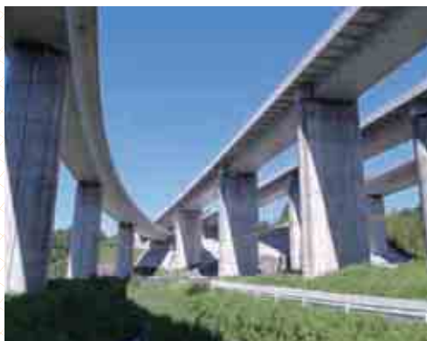
新東名高速道路 的場高架橋
