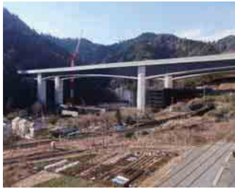
裏高尾橋全景
